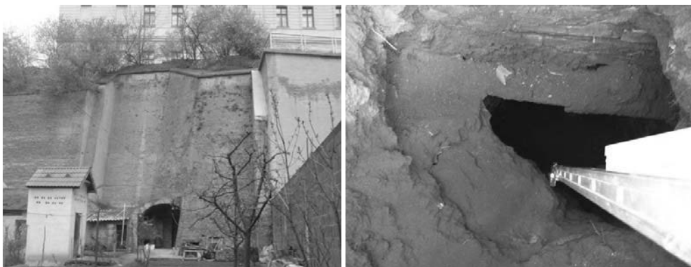
Slika 8. Stari nedržavani zid u podnožju (lijevo) i pronalazak „kaverne“ uz temelj vukovarske gimnazije (desno) [6]
