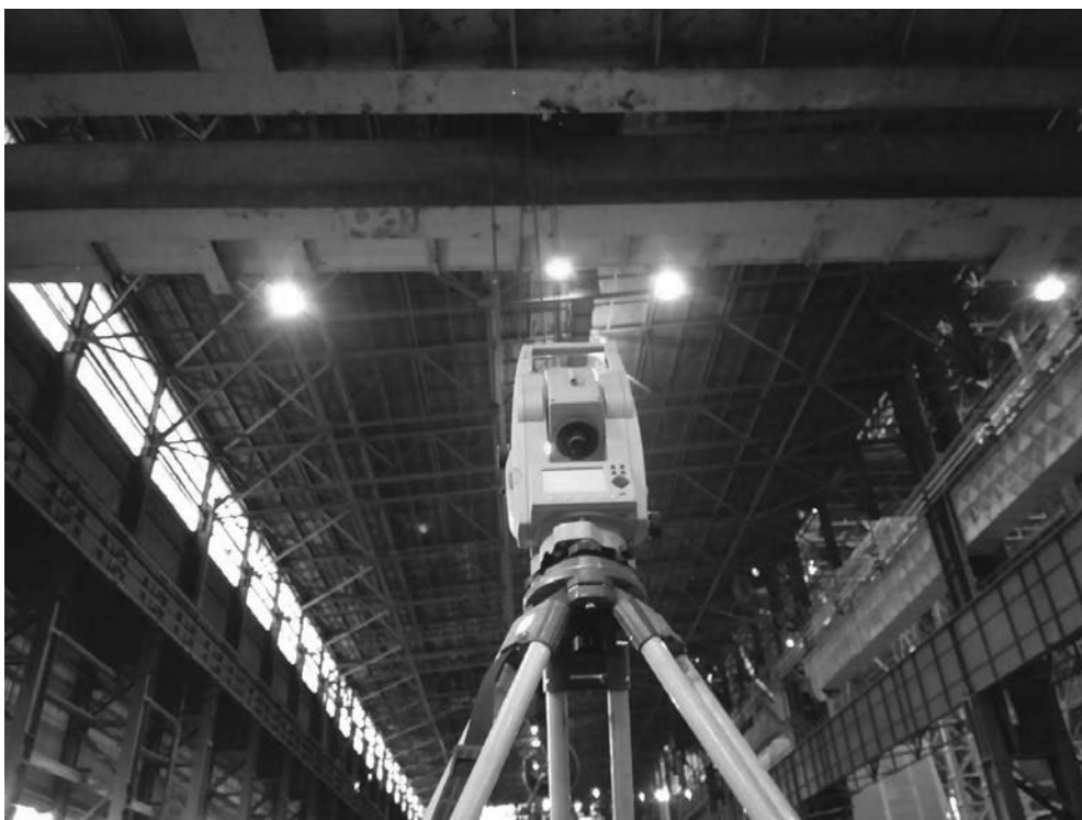
Slika 3. Primjer mjerenja ugiba mosta dizalice tokom statičkog probnog ispitivanja
